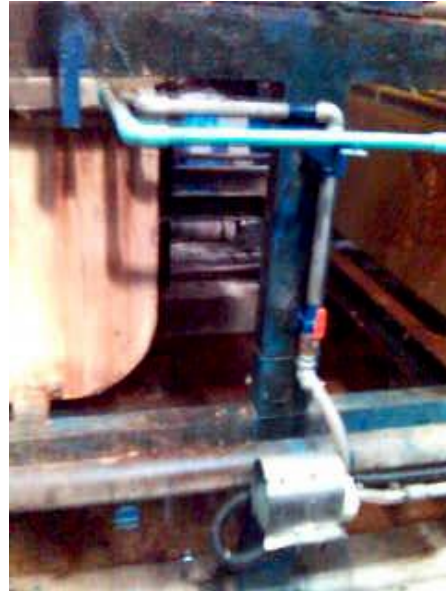
รูปที่ 10.6 ถังพักน้ำร้อนและเครื่องสูบน้ำกลับจากบ่อที่ 7 ไปยังบ่อที่ 5
