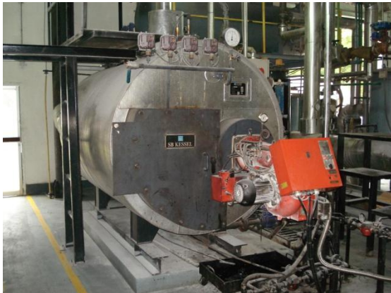
รูปที่ 10.7 หม้อไอน้ำและสถานะการทำงาน (Low Fire)
