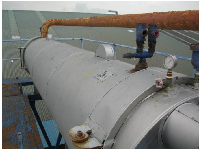
รูปที่ 9.11 Tank และ Heat Exchanger ที่ติดตั้ง
