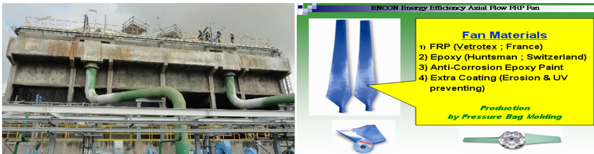
รูปที่ 8.10 หอผึ่งน้ำที่ดำเนินการ
