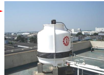
รูปที่ 8.9 ระบบหล่อเย็นที่ใช้งานในส่วนเครื่องทำน้ำเย็นและส่วนของ Evaporation (หลังปรับปรุง)
