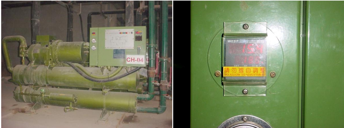
รูปที่ 6.8 Chiller, อุณหภูมิ Set Point และอุณหภูมิน้ำเย็นด้านออก
