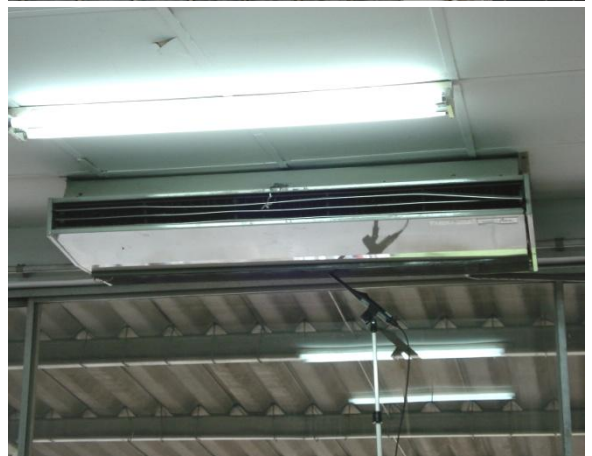
รูปที่ 5.10 เครื่องปรับอากาศแบบแยกส่วน (ก่อนปรับปรุง)
