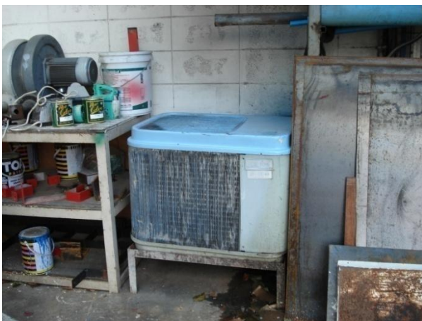
รูปที่ 5.10 เครื่องปรับอากาศแบบแยกส่วน (ก่อนปรับปรุง)
