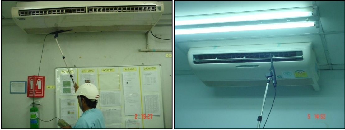
รูปที่ 5.4 ตัวอย่างการตรวจวัดอุณหภูมิ ความชื้น Return – Supply
