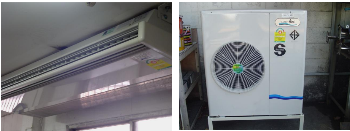
รูปที่ 5.11 เครื่องปรับอากาศแบบแยกส่วน (หลังปรับปรุง)
